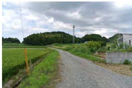
写真 5-6 砂利敷の進入路 (鉄塔の手前が指定地)
