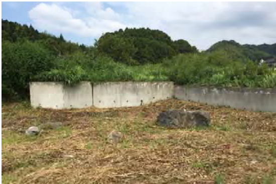
写真 4-13 コンクリート擁壁 2
