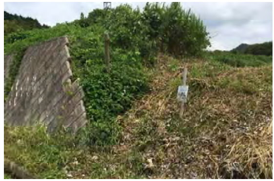
写真 4-12 コンクリート擁壁 1
