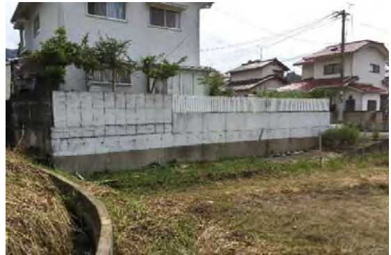
写真 4-14 コンクリート擁壁 3
