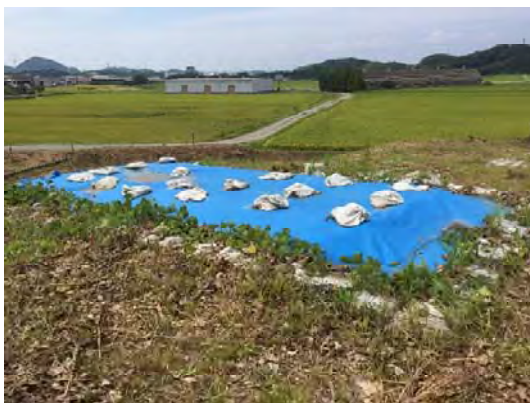
写真5-1 石室上部に架けたブルーシート
