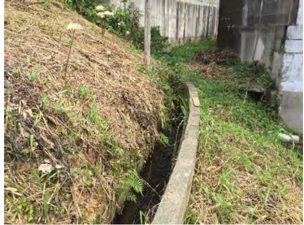
写真 5-3 史跡内を通る基幹用水路
