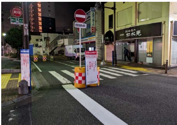
設置された仮設標識・看板。
