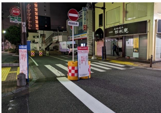
設置された仮設標識・看板。
