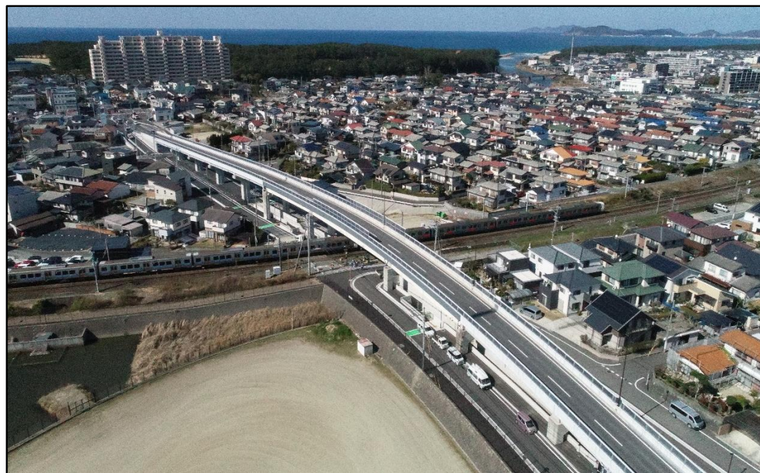
整備が完了した「浜大塚線」
