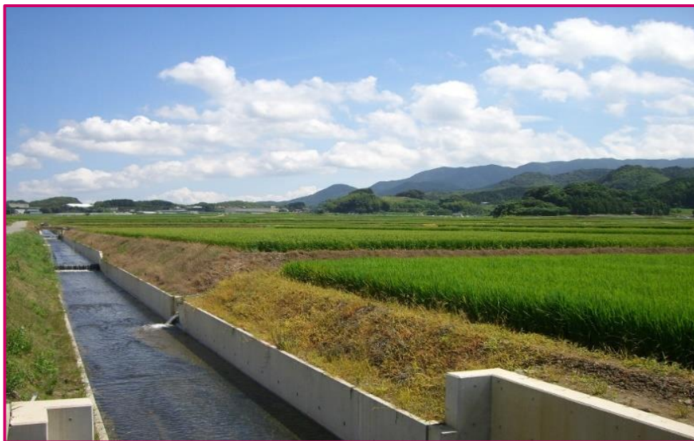
整備された小野南部地区の水路とほ場
