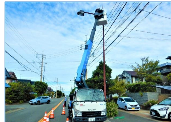
道路照明灯 点検の様子
