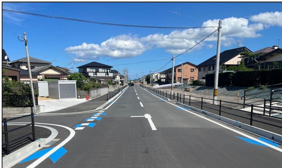
整備が完了した西鉄跡地
