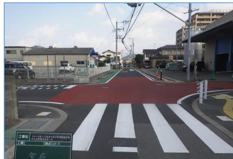
道路舗装補修工事（完了）
