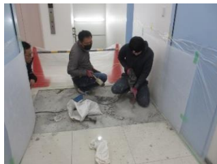
下地材を剥がした状態
