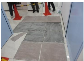
タイルを剥がした状態
