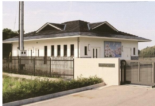
小山田甕水センター
