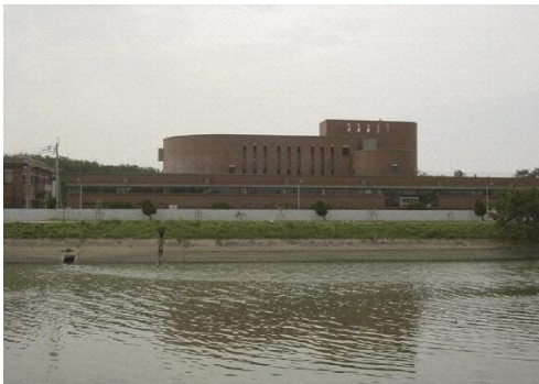
古賀水再生センター
