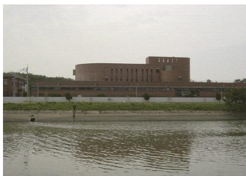
古賀水再生センター
