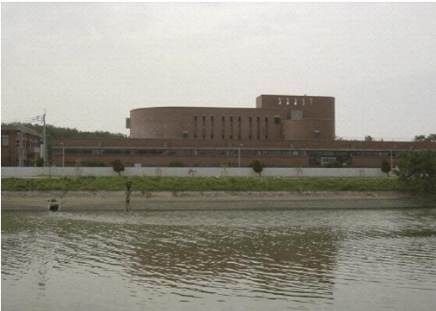
古賀水再生センター
