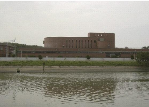
古賀水再生センター
