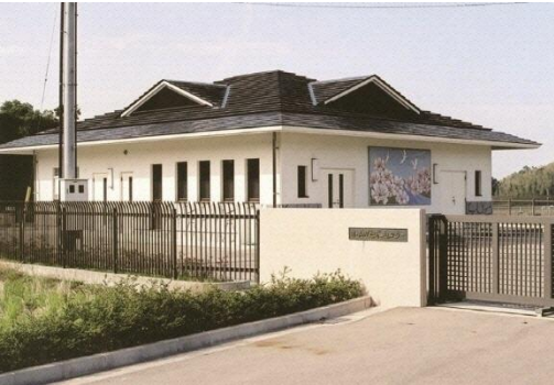
小山田甕水センター
