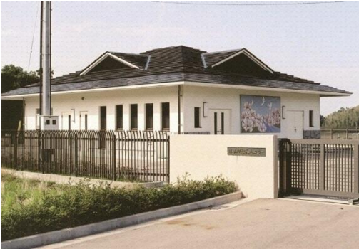
小山田甕水センター
