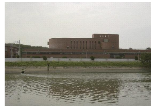
古賀水再生センター
