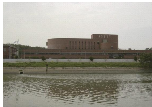
古賀水再生センター
