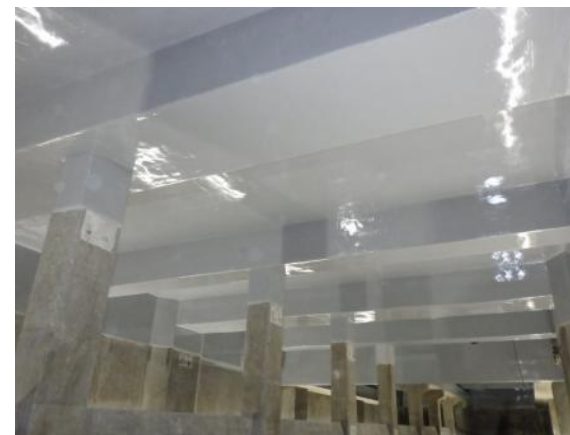
令和4年度 古賀水再生センターNo.3 最初沈殿池防食工事
