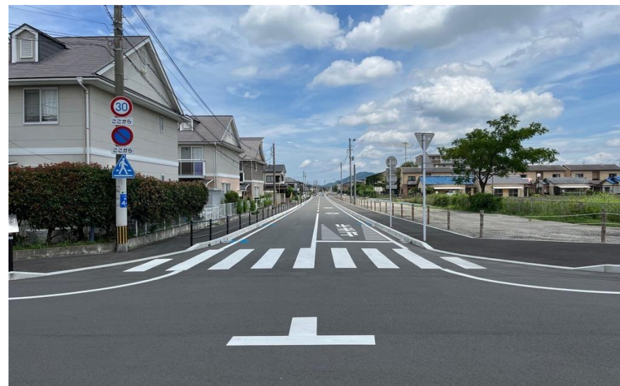
整備された道路の状況（中川区）
