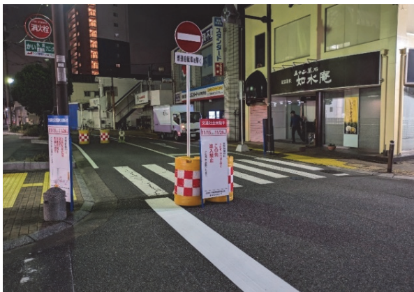
設置された仮設標識・看板。
