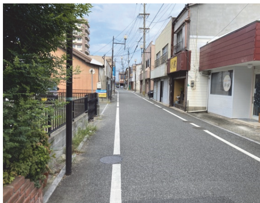
道路の現況（線路沿い）
